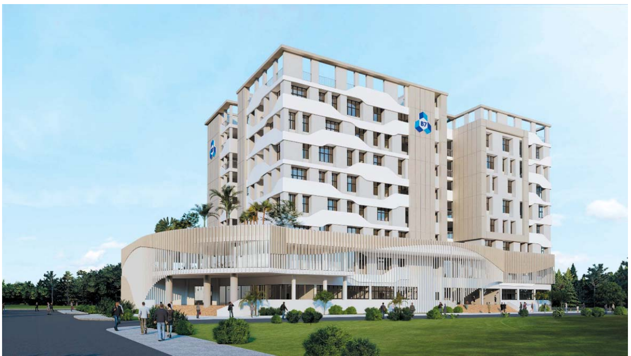
Công trình Nhà học tập và thí nghiệm BK.B7. Hình đồ họa
